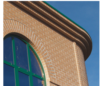
▲ Sonderbauteile Attika-Gesims
