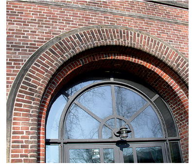
▲ Gemauerter Rundbogen
