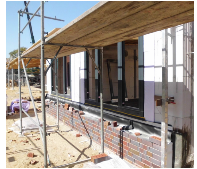
▲ Z-Abdichtung im Fensteranschlussbereich © Alexander Osthues
