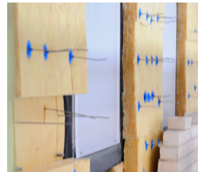
▲ Ausführungsbeispiel: Eingelegte Luftschichtanker
