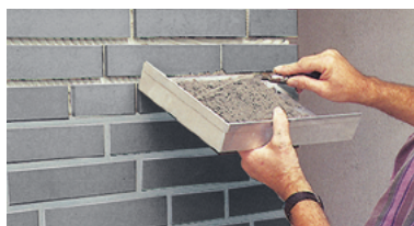
▲ Sauberes Verfugen mit Fugeisen und Fugblech
