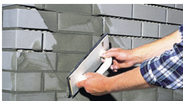
▲ Im Schlamm-Verfahren werden die Fugen diagonal mit einem Putzbrett verfüllt
