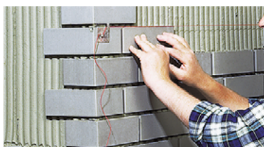
▲ Setzen der Flächenriemchen mit Hilfe einer Schnur
