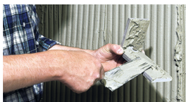
▲ Klebeauftrag im kombinierten Verfahren „Buttering-Floating“
