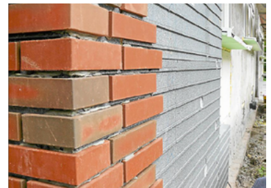
▲ Beispiel eines Fugenleitsystems als Alternative
