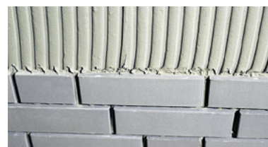
▲ Keramische Riemchen vollständig in Kleber eingebettet
